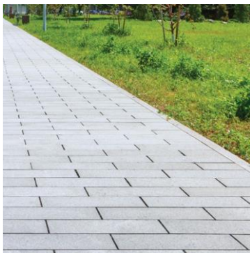
nawierzchnia z kostki betonowej
